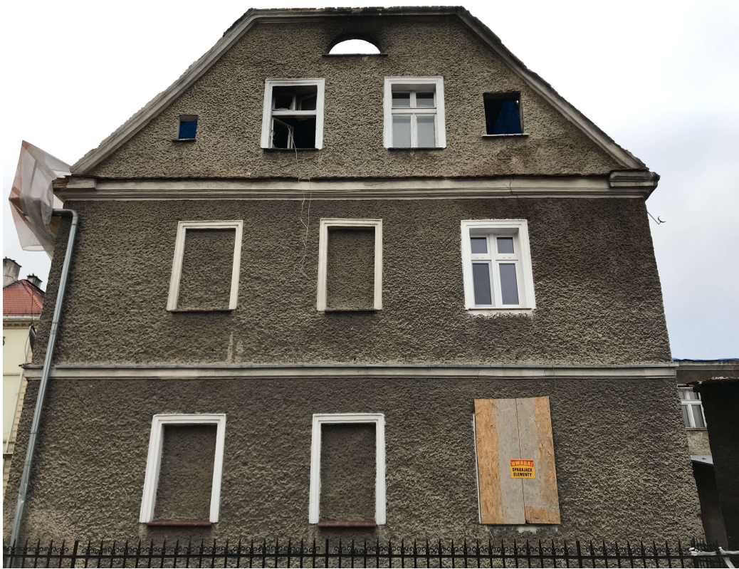
Fot. 3 Elewacja wschodnia, ściana szczytowa - widok po usunięciu pogoźeliska. Rok 2019
