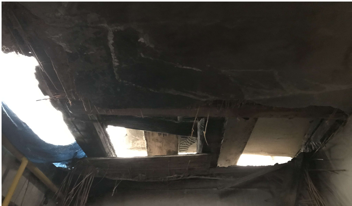
Fot. 4 Konstrukcja stropu po uprzątnięciu pogoźeliska. 2019
