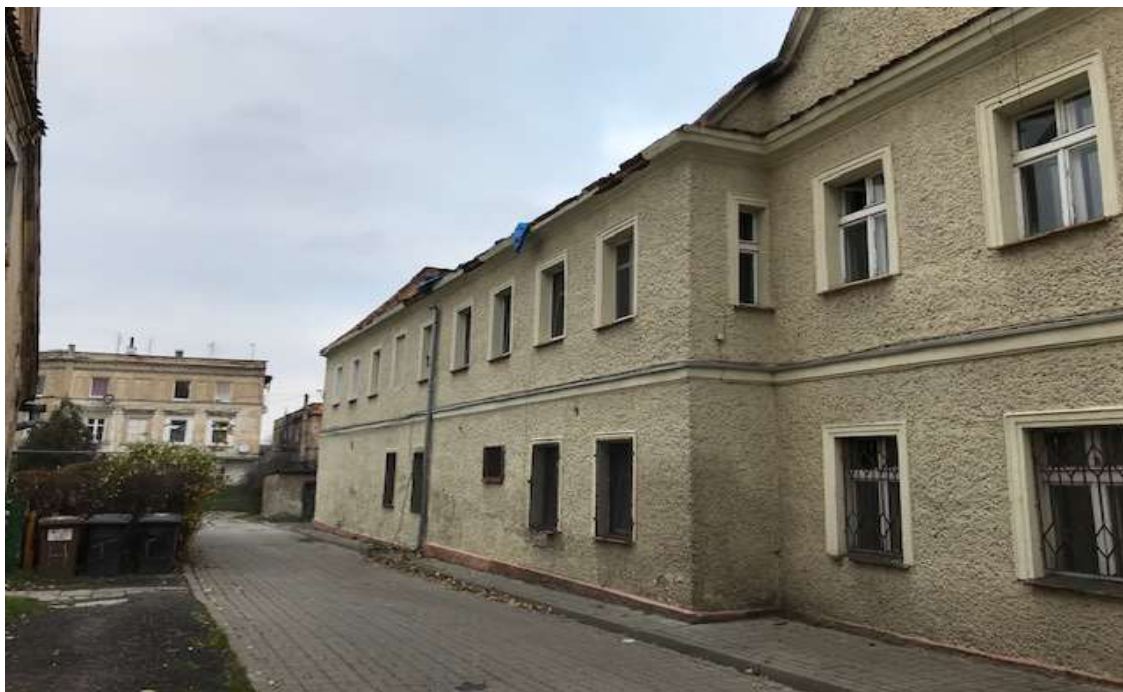
Fot. 10 Elewacja zachodnia od ul. Kwiatowej.
