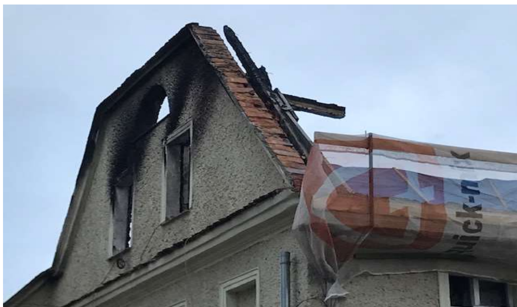
Fot. 3 Ściana szczytowa od ul. Kwiatowej - widok po usunięciu pogoźeliska. Rok 2019
