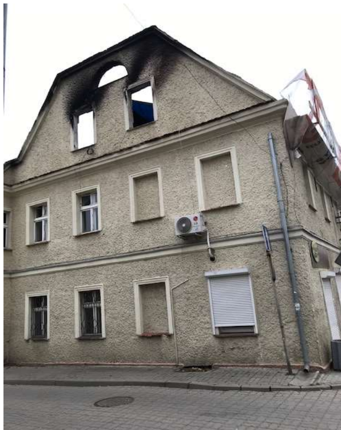
Fot. 3 Ściana szczytowa od ul. Kwiatowej - widok po usunięciu pogoźeliska. Rok 2019
