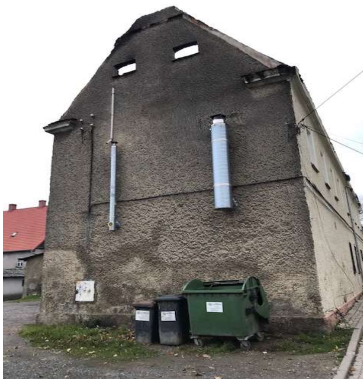
Fot. 8 Ściana szczytowa – elewacja północna
