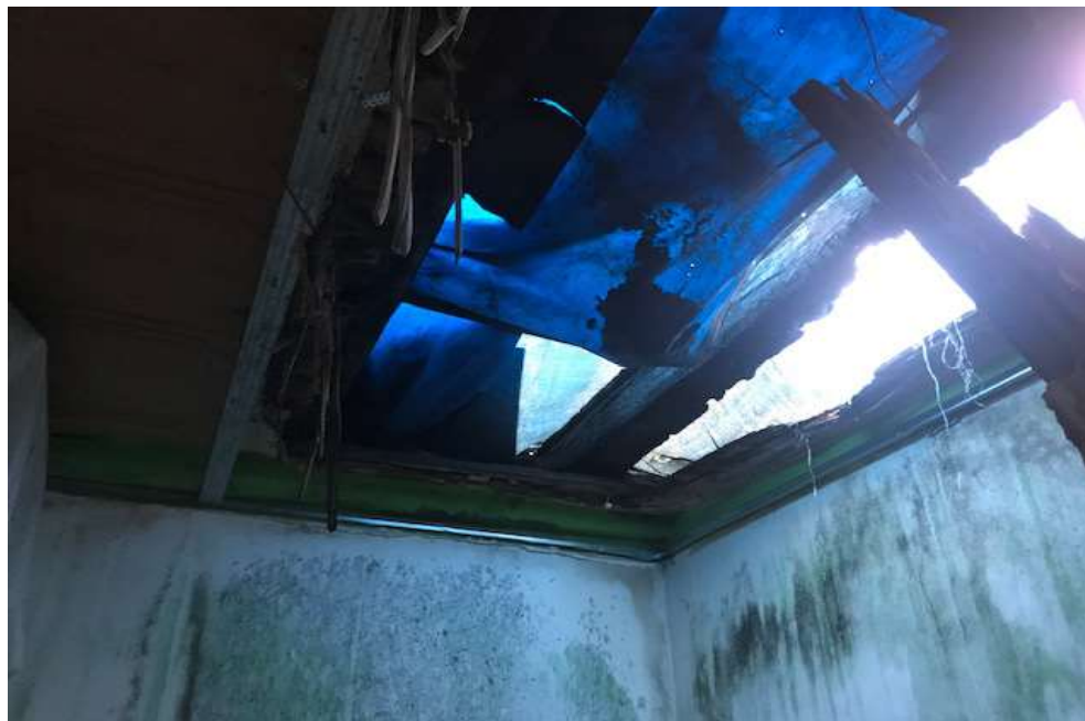
Fot. 6 Konstrukcja stropu nad I piętrem - widok po usunięciu pogożeliska
